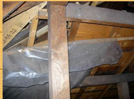
長い年月、雨や雪から私たちを守っていましたが、屋根の腐食によって雨漏りの被害が増え、その為の修復が行われましたが一部にビニールを貼り付けているだけのものとなっています。
