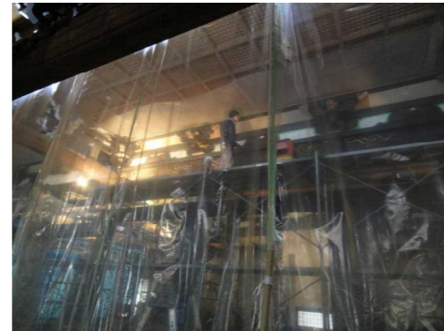
現場をビニールで覆い、ホコリを立てないように気をつけながら作業をしています。
